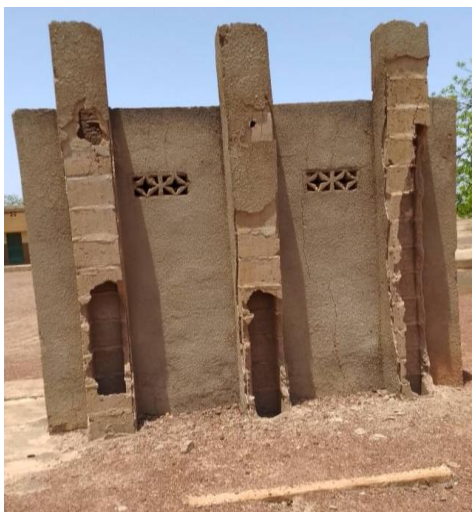
Photo 7 : Vue de dos des latrines avec leurs conduites d'aération détruites diffusant les mauvaises odeurs dans l'enceinte de l'école de Zipèlin
