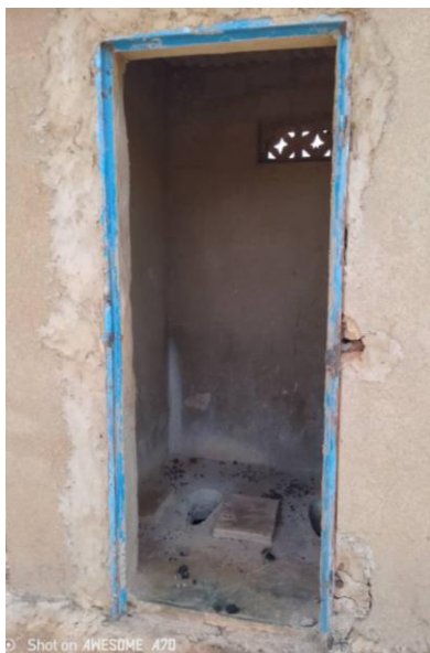
Photo 8 : Mise évidence des latrines sans porte, de la porte abimée et de certains creux (trous)
