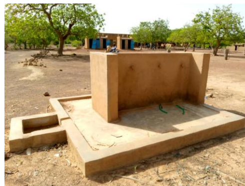
Photo N°4 : Dispositif de six robinets (installés de part et d'autre du dispositif) servant à desservir les élèves en besoin en eau potable à partir du château d'eau
