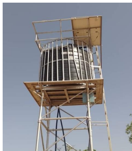
Photo N°3 : Château d'eau d'une capacité de 5000 litres réalisé par OCADES/PAM pour l'école, mais actuellement non fonctionnel dû à des dommages sur les plaques solaires causés par un vent violent
