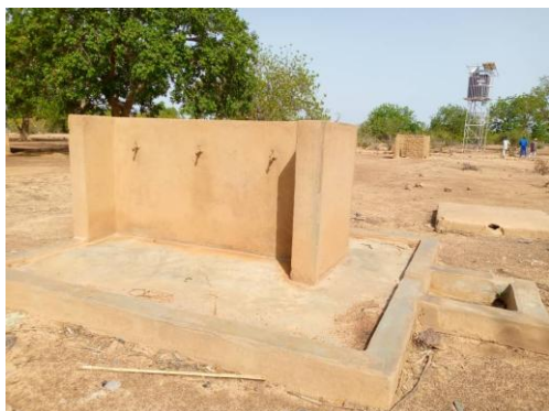
Photo N°4 : Dispositif de six robinets (installés de part et d'autre du dispositif) servant à desservir les élèves en besoin en eau potable à partir du château d'eau
