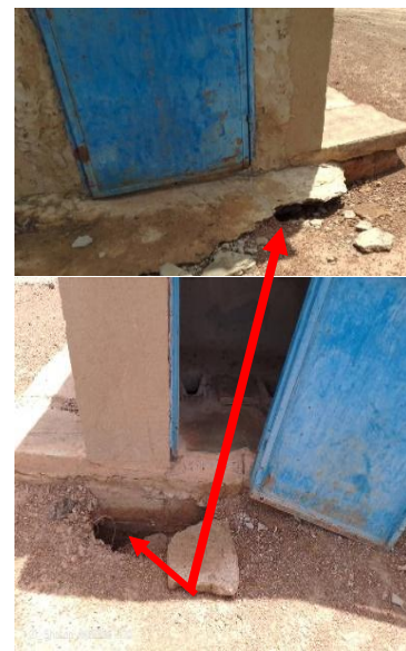
Photo 8 : Mise évidence des latrines sans porte, de la porte abimée et de certains creux (trous)
