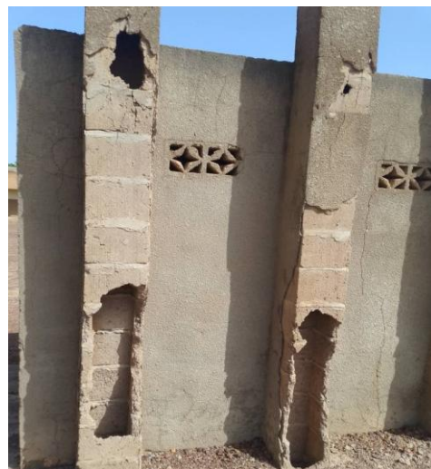
Photo 7 : Vue de dos des latrines avec leurs conduites d'aération détruites diffusant les mauvaises odeurs dans l'enceinte de l'école de Zipèlin
