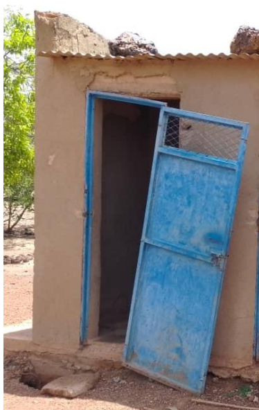
Photo 8 : Mise évidence des latrines sans porte, de la porte abimée et de certains creux (trous)
