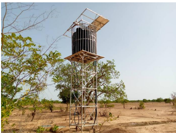
Photo N°3 : Château d'eau d'une capacité de 5000 litres réalisé par OCADES/PAM pour l'école, mais actuellement non fonctionnel dû à des dommages sur les plaques solaires causés par un vent violent
