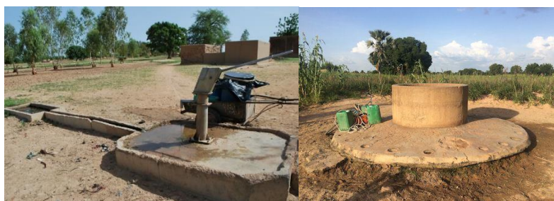
La pompe manuelle à l'école et le puits à grand diamètre du quartier
